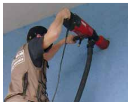
Jadrové vŕtanie do muriva s odsávaním prachu, suchý proces, ručné držanie.
