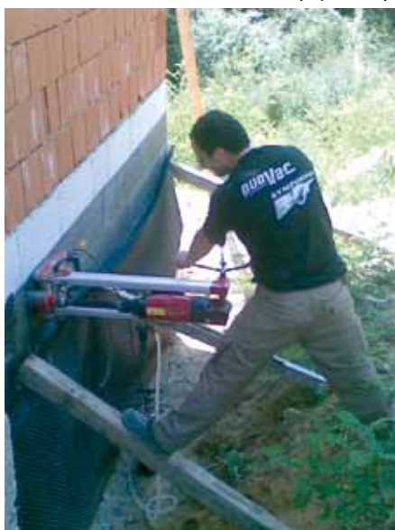
Jadrové vŕtanie do muriva s odsávaním prachu, suchý proces, ručné držanie.
