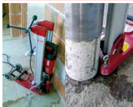
Vŕtanie do železobetónu na mokro, stojanové držanie - umožňuje vŕtať pod uhlom.
