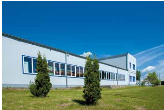
Zrekonštruovaná budova novej nástrojárne spoločnosti Tatramat – ohrievače vody, s.r.o.
