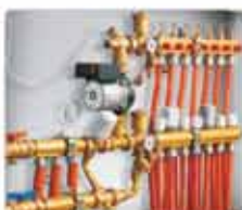
rozdeľovače pre radiátorové, podlahové, stenové, stropné vykurovanie a chladenie
