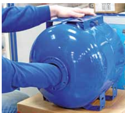
4/ Skontrolujte nádobu z vnútornej strany v mieste zvaru. Môže tu byť ostrá hrana alebo kovová špona. Na týchto miestach sa gumový vak pri jeho neustálom pohybe v dôsledku meniaceho sa tlaku obrusuje a jeho stena sa stenčuje až do momentu prasknutia.
