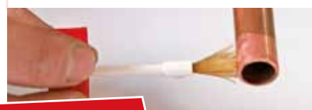
1/ Štetcom nanesieme na spájané miesta rúrky i kolienka pastu GRIFON S-39 UNIVERSAL.
