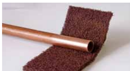
1/ Pomocou rúna očistíme koniec rúrky.
