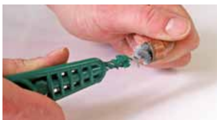
2/ Pomocou kefy očistíme vnútorný priemer pripájaného kolienka.
