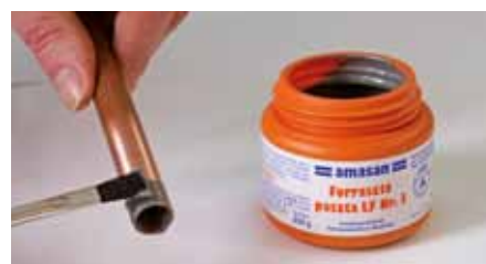
3/ Štetcom nanesieme pastu na očistenú časť rúrky i kolienka.
