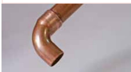
2/ Takto pripravené kusy spojíme a môžeme spájkovať.
