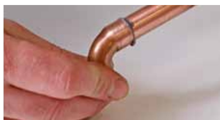
4/ Takto pripravené kusy spojíme a môžeme spájkovať.
