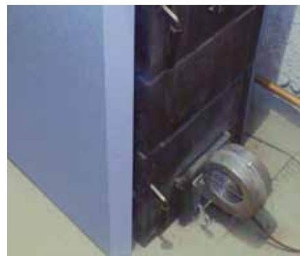
Ventilátor umiestnený na dvierkach kotla.
